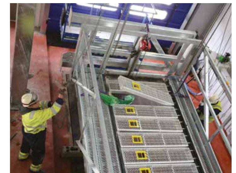
Preparación para la elevación de la jaula VELP dentro del edificio del cliente
