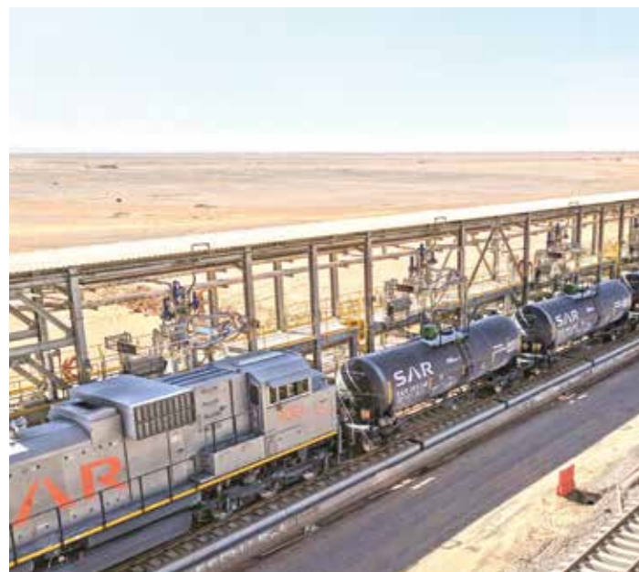
Pasarelas sobre orugas con brazo de carga y patines contadores para Ácido - Arabia Saudí - Industria Química
