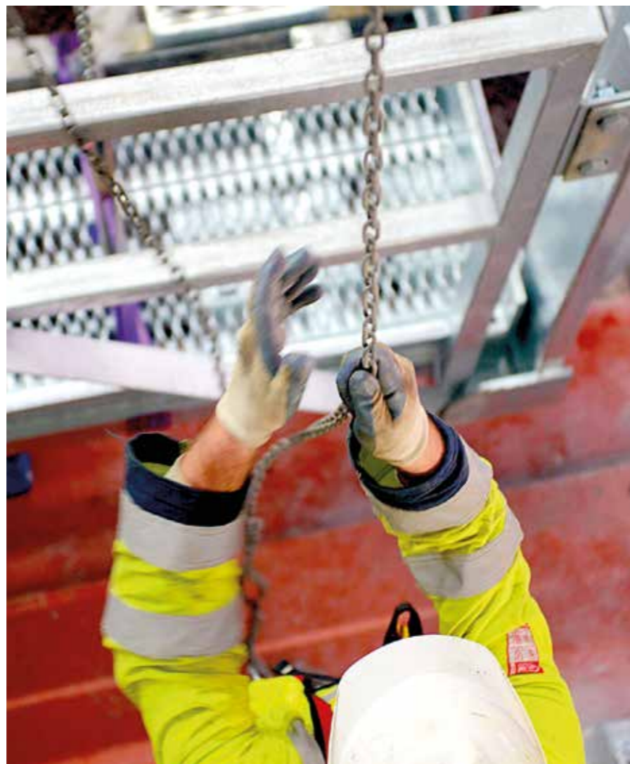
Preparación para la elevación de la plataforma VELP en el interior del edificio del cliente
