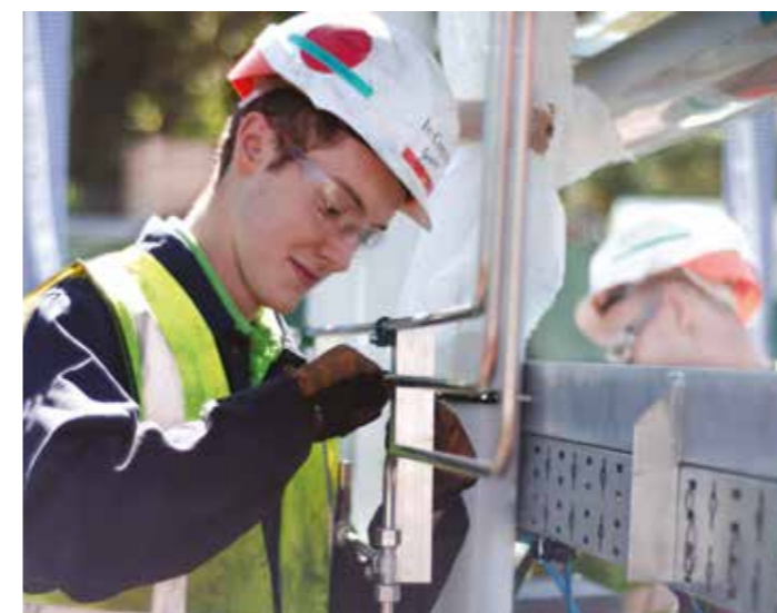
Tubería de acero inoxidable para la instalación de patines
