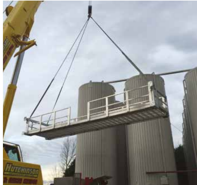
Instalación de la sección de la jaula VELP
